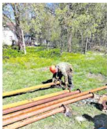
● Замена водоподъемных колонн на скважинах с. Липицы, Серпухов-12
