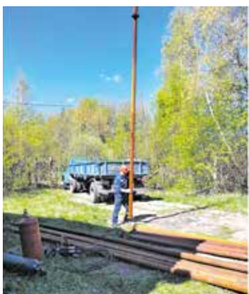
● Замена водоподъемных колонн на скважинах с. Липицы, Серпухов-12
