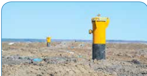
В теле полигона пробурено 20 газовых скважин.
