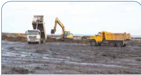
Проводится пересыпка карт полигона грунтом и дополнительное тампонирующее скважин. Для этих целей на полигон ТКО «Лесная» ежедневно заводится до 2 тысяч кубометров грунта.
