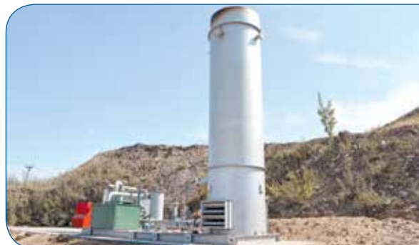
Эффективность обезвреживания свалочного газа в высокотемпературном факеле выше 99%. – время задержания свалочного газа в камере сгорания не менее 3 с, – минимальная концентрация метана (CH 4 ) 12% об. (без дополнительного топлива, без нагревания и при 0% кислорода).
