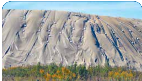
20 тысяч кв. м восточного склона тела полигона укрыты геосинтетической тканью, не позволяющей газу «мигрировать».
