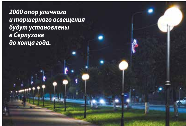
Идет установка новых опор.
