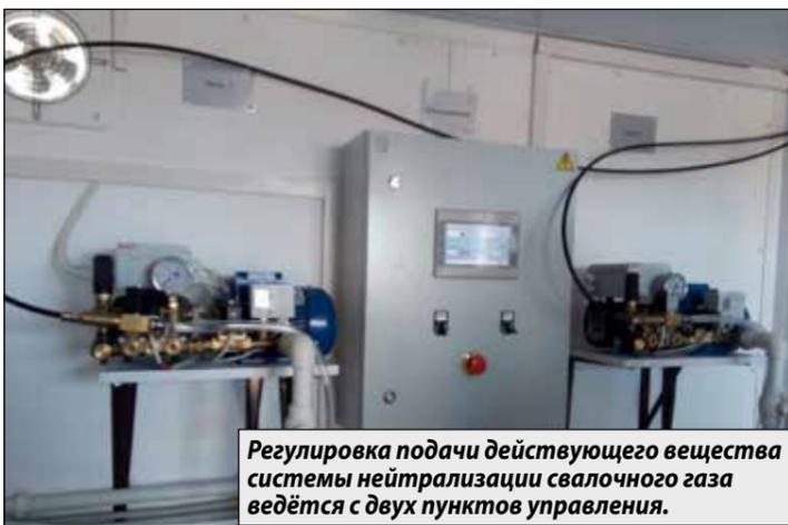
Регулировка подачи действующего вещества системы нейтрализации свалочного газа ведётся с двух пунктов управления.
