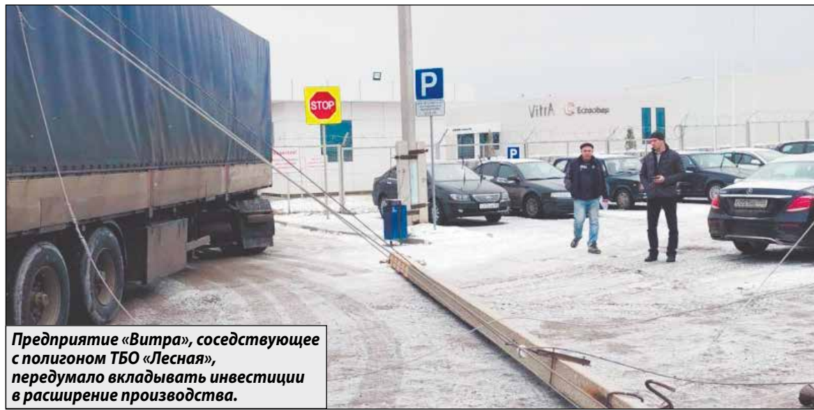
Городское поселение «Пролетарский»: «Поросшая» сосульками теплотрасса, обогревающая улицы и неблагоустроенные дворы – общие приметы районной сферы ЖКХ.
