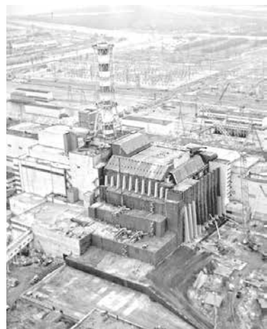
● Строительство купола «саркофага» над четвертым энергоблоком Чернобыльской АЭС.
