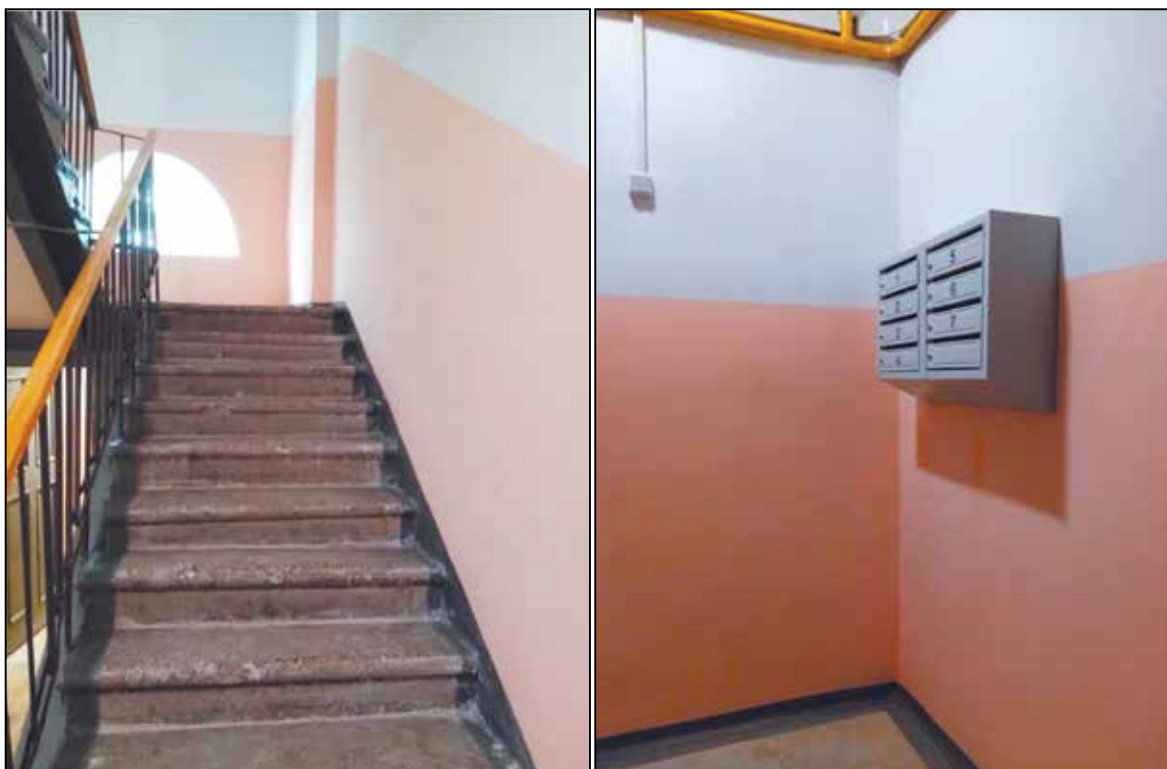
Пл. 49-й Армии, д.№ 9, подъезд 2 после ремонта
