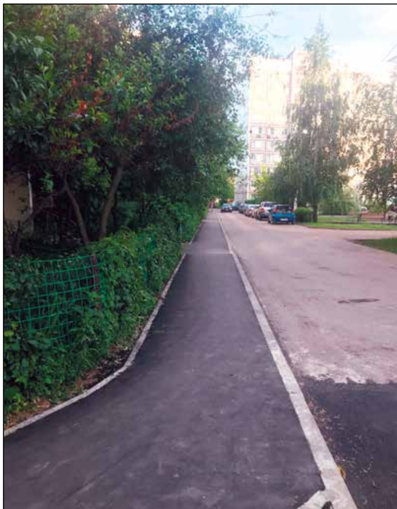
Новый тротуар на ул. Глазовской, 32
