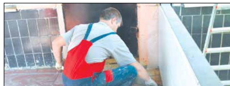
В учреждениях образования г.о. Серпухов начались ремонтные работы в рамках подготовки к новому учебному году
