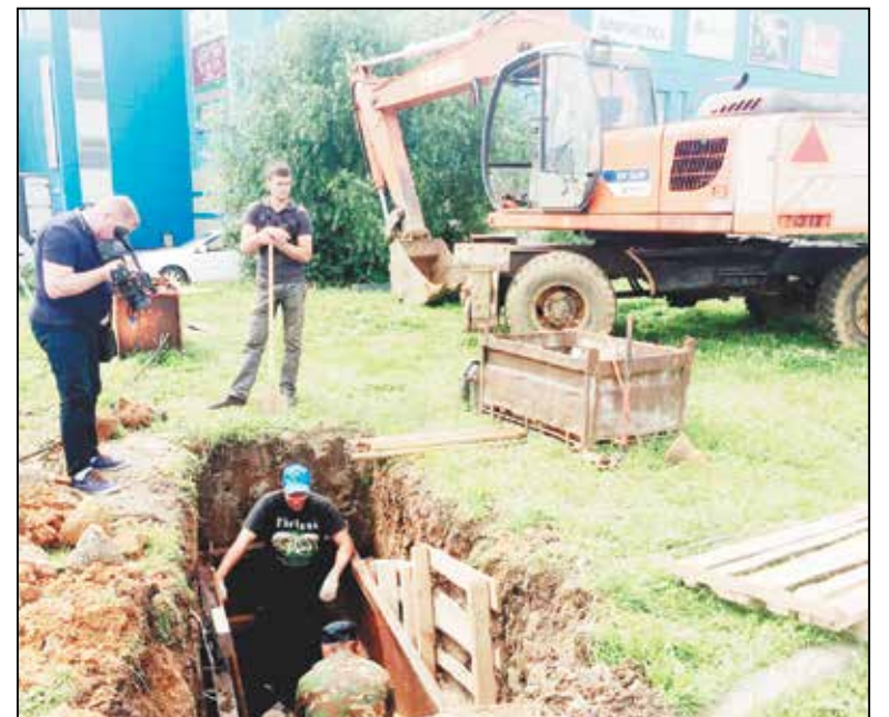
Коммунальщики обустривают ливневую канализацию
