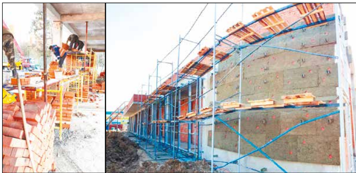
Строительство идет с опережением графика
