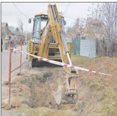
Участок трубопровода проложили в Дашковке в 2019 году
