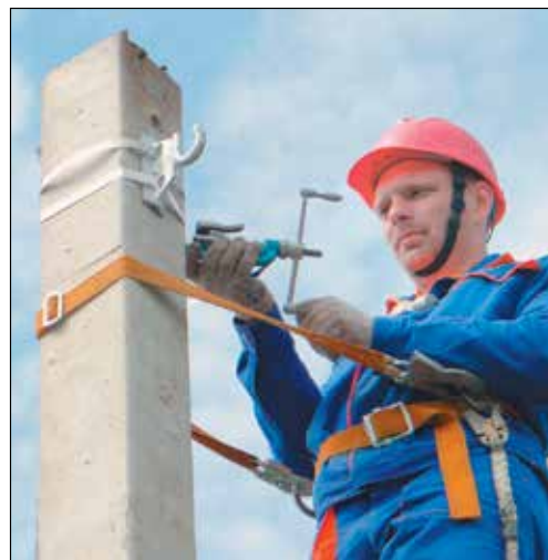
Будет установлено более 3000 светодиодных светильников
