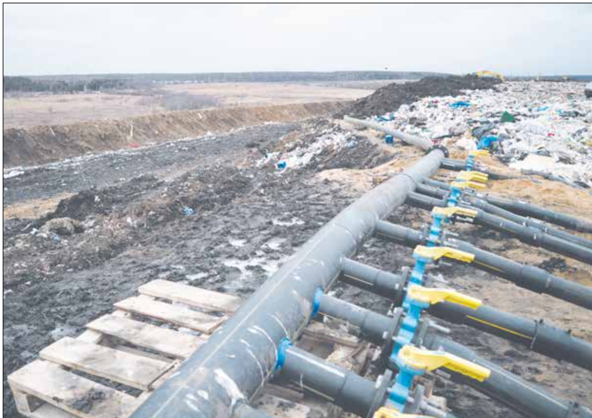
Для переподключения факелов на отдельные магистрали пришлось остановить систему дегазации на 4 часа
